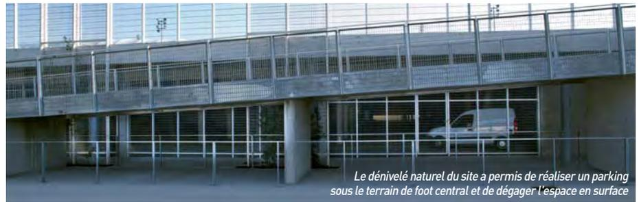
Le dénivelé naturel du site a permis de réaliser un parking sous le terrain de foot central et de dégager l'espace en surface
