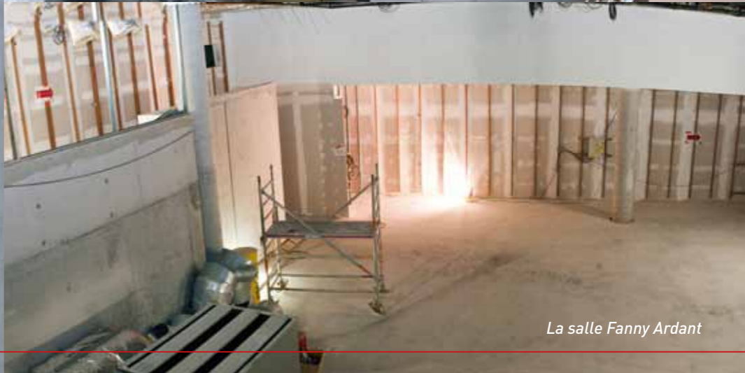
Le futur hall d'entrée
