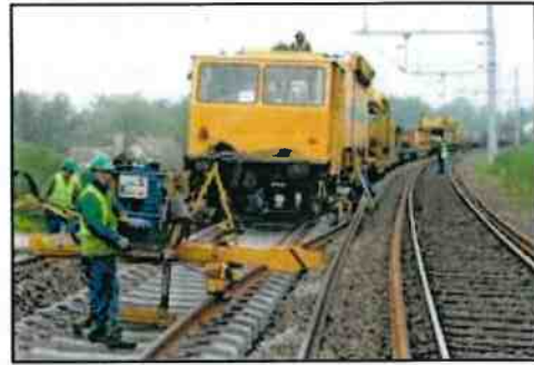
Longs Rails soudés sur traverses béton
