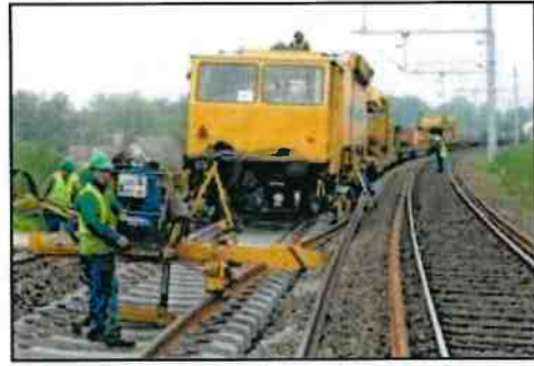
Longs Rails soudés sur traverses béton
