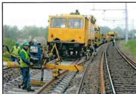
Longs Rails soudés sur traverses béton
