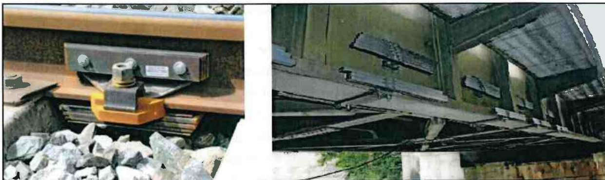
Exemples d'absorbeurs sur rail
