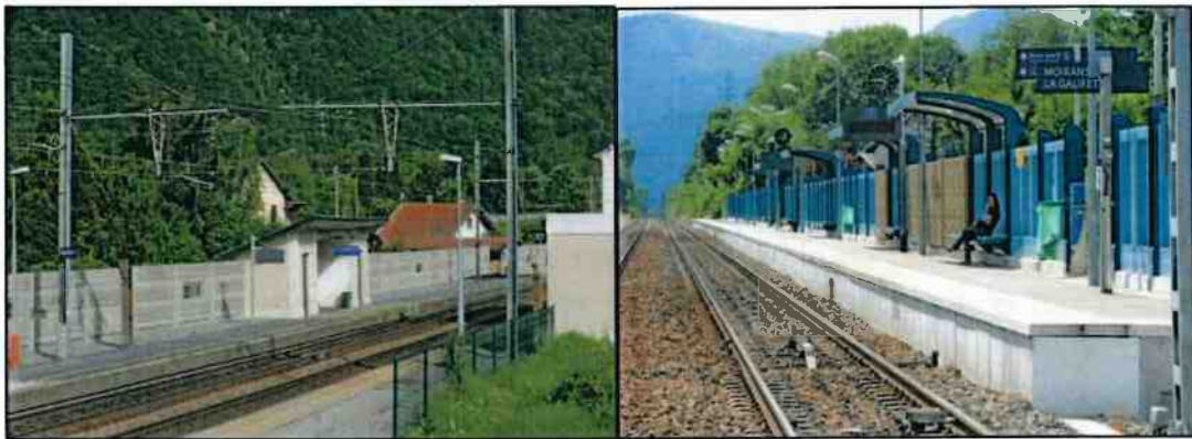
Exemples d'écrans acoustiques à Aiguebelle et Moirans
