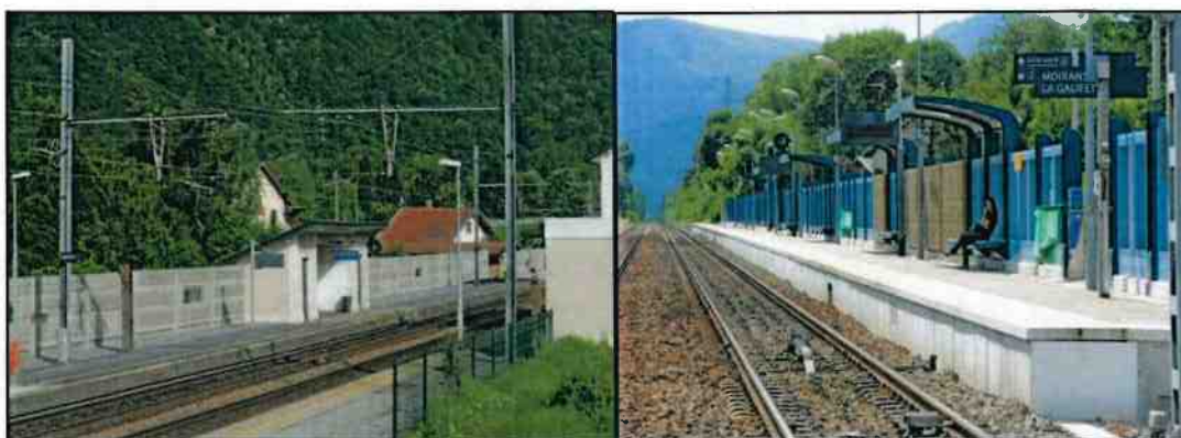
Exemples d'écrans acoustiques à Aiguebelle et Moirans
