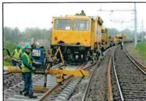
Longs Rails soudés sur traverses béton
