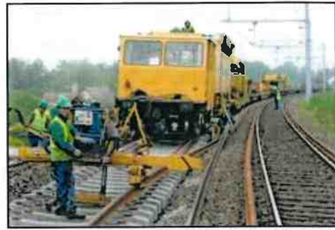
Longs Rails soudés sur traverses béton
