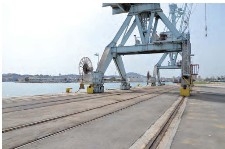
Port de Brégailion : les voies ferrées en bord de quai à réhabiliter.
