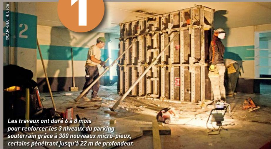
Les travaux ont duré 6 à 8 mois pour renforcer les 3 niveaux du parking souterrain grâce à 300 nouveaux micro-pieux, certains pénétrant jusqu'à 22 m de profondeur.
