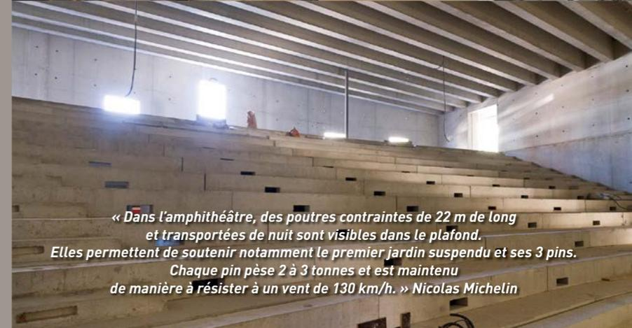
« Dans l'amphithéâtre, des poutres contraintes de 22 m de long et transportées de nuit sont visibles dans le plafond. Elles permettent de soutenir notamment le premier jardin suspendu et ses 3 pins. Chaque pin pèse 2 à 3 tonnes et est maintenu de manière à résister à un vent de 130 km/h. » Nicolas Michelin
