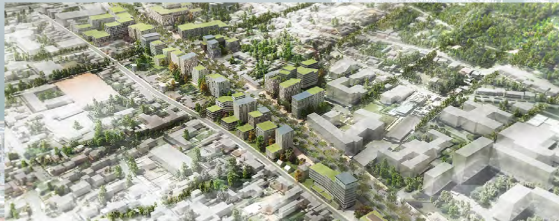
La ZAC Rouget de Lisle du Grand Paris à Vitry-sur-Seine (2014-2019)
