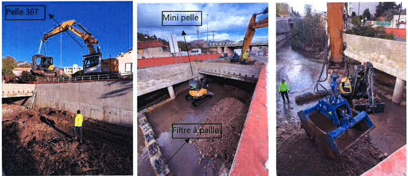
FIGURE 9 : PHOTOGRAPHIES DE LA METHODE MISE EN PLACE LORS DU CURAGE D'ESSAI
