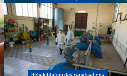
Réhabilitation des canalisations
