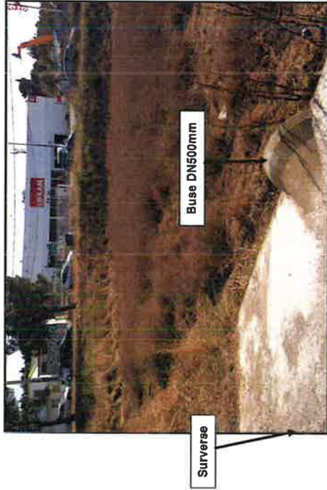
Figure 5 : Vue sur le bassin de rétention des Plantades existant et son ouvrage de sortie
