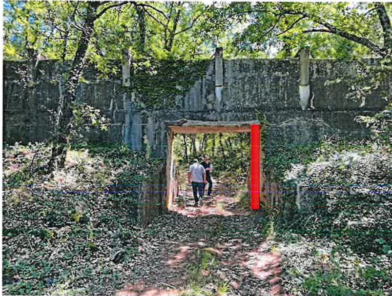
Projet d'étalement contre la culée amont.
