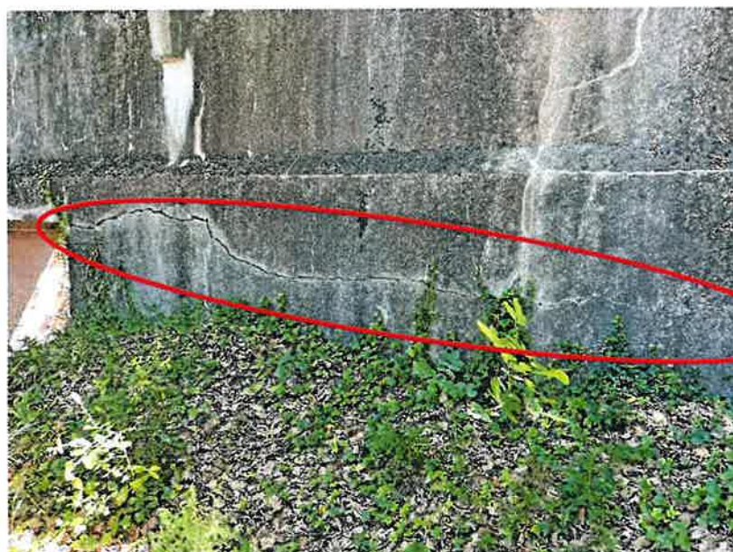
Vue d'ensemble de la fissure horizontale
