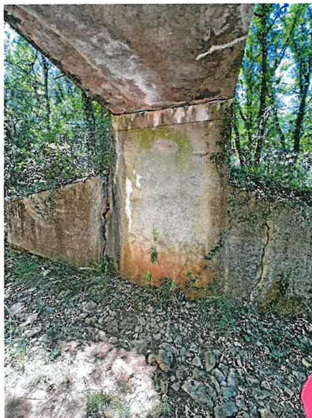
Vue de la sous face du tablier : traces de calcaire et décollement de l'enduit
