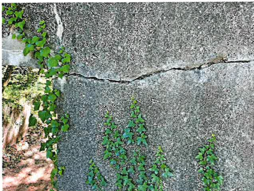
Détail de la fissure horizontale
