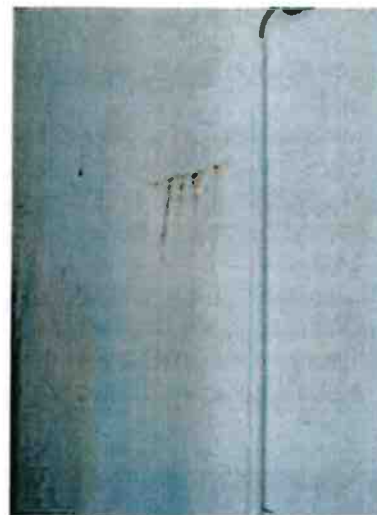
Percolation des voiles BA dans le local de refoulement
