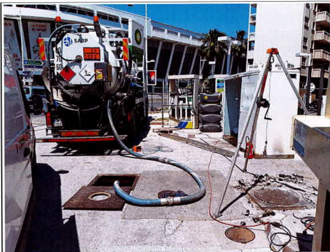
Photographie n°3 : Opérations de nettoyage et dégazage des cuves de carburants n°1 et n°2 (Zone Z1)
