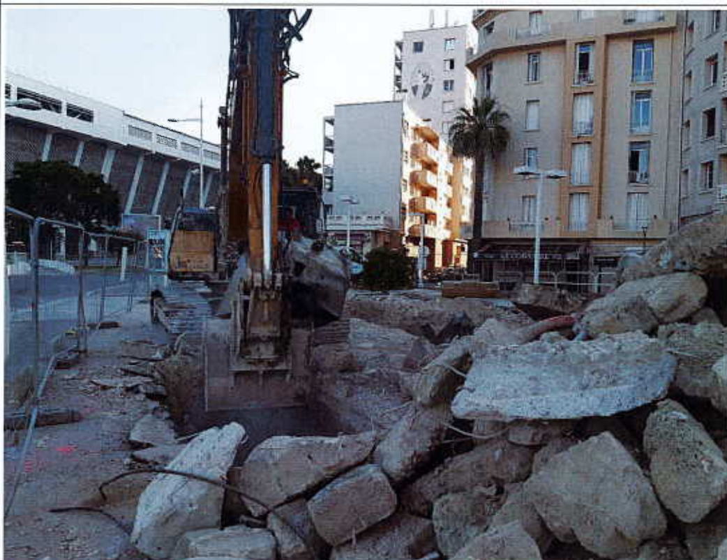
Photographie n°10 : Opération de démantèlement du séparateur d'hydrocarbures n°1 (Zone Z7)
