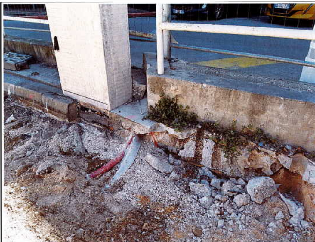
Photographie n°11 : Emplacement de l'ancienne cuve n°8 (inertée au béton) - Zone Z6
