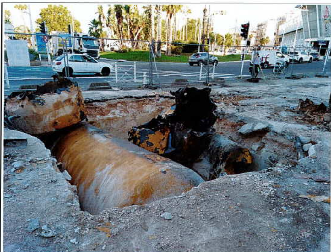
Photographie n°5 : Opérations de démantèlement des cuves n°3 et n°4 (Zone Z2)
