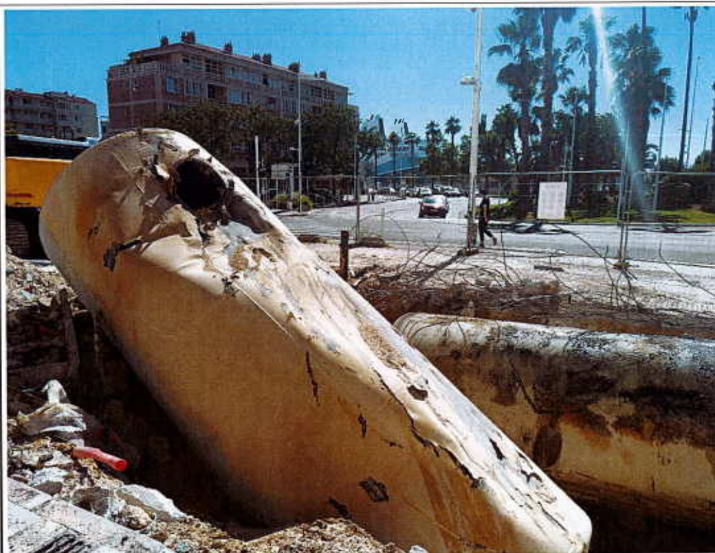
Photographie n°4 : Opérations de démantèlement des cuves n°1 et n°2 (Zone Z1)
