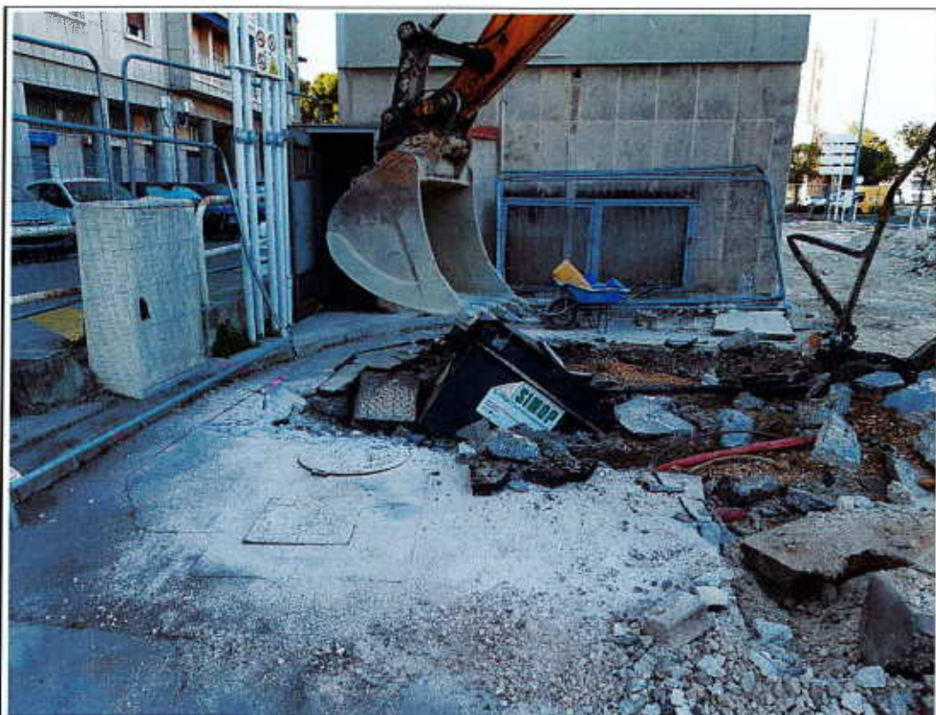
Photographie n°9 : Opération de démantèlement du séparateur d'hydrocarbures n°2 (Zone Z6)
