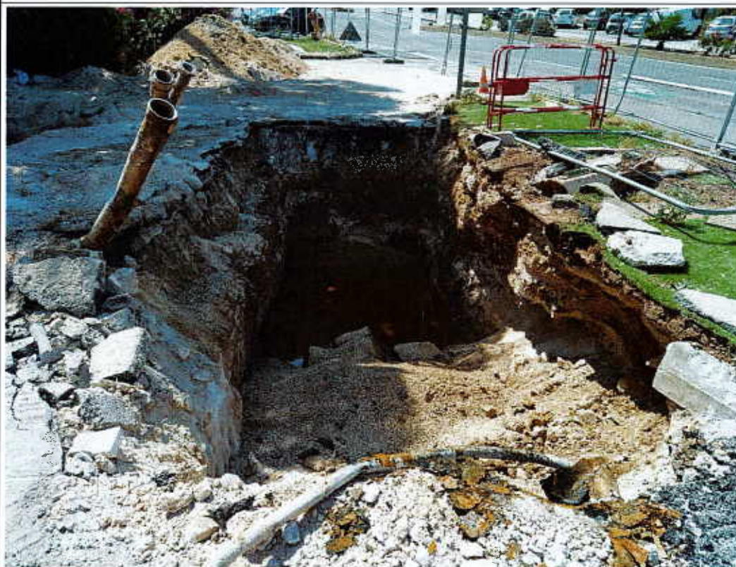
Photographie n°6 : Opérations de démantèlement de la cuve n°5 (Zone Z3)
