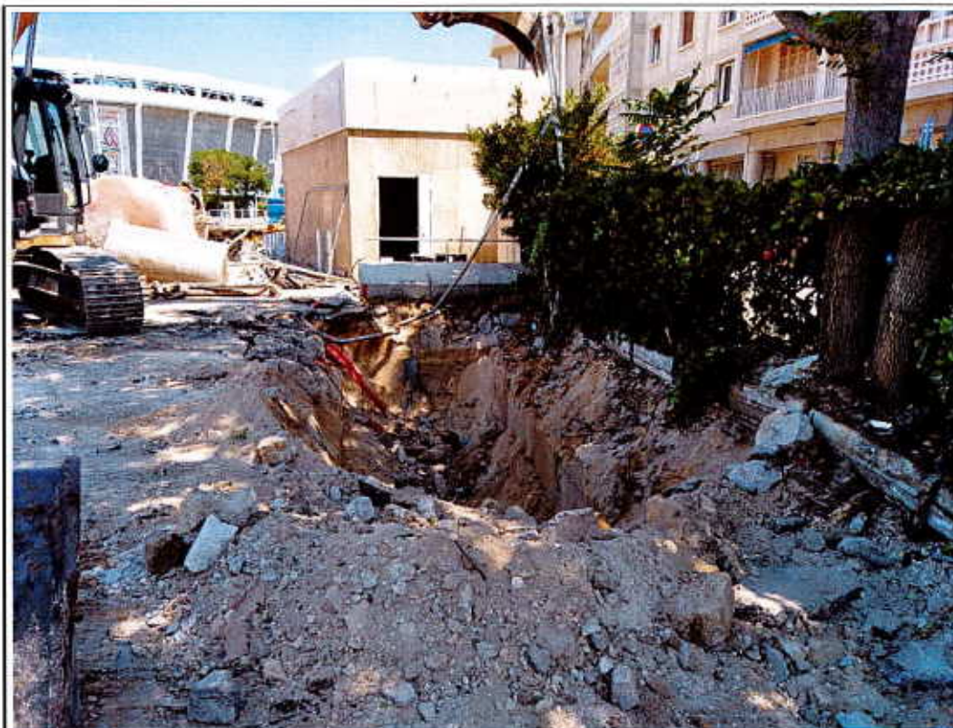
Photographie n°7 : Opérations de démantèlement de la cuve n°6 et de l'aire de dépotage (Zone Z4)
